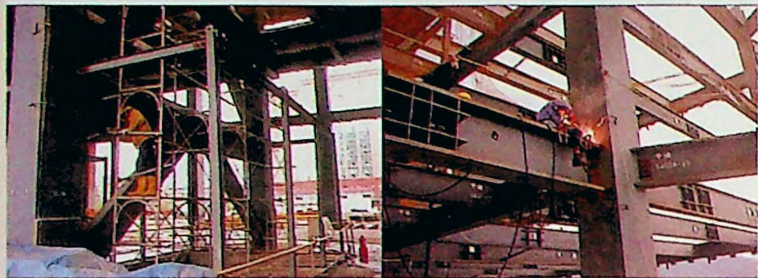
鋼骨架構組立
