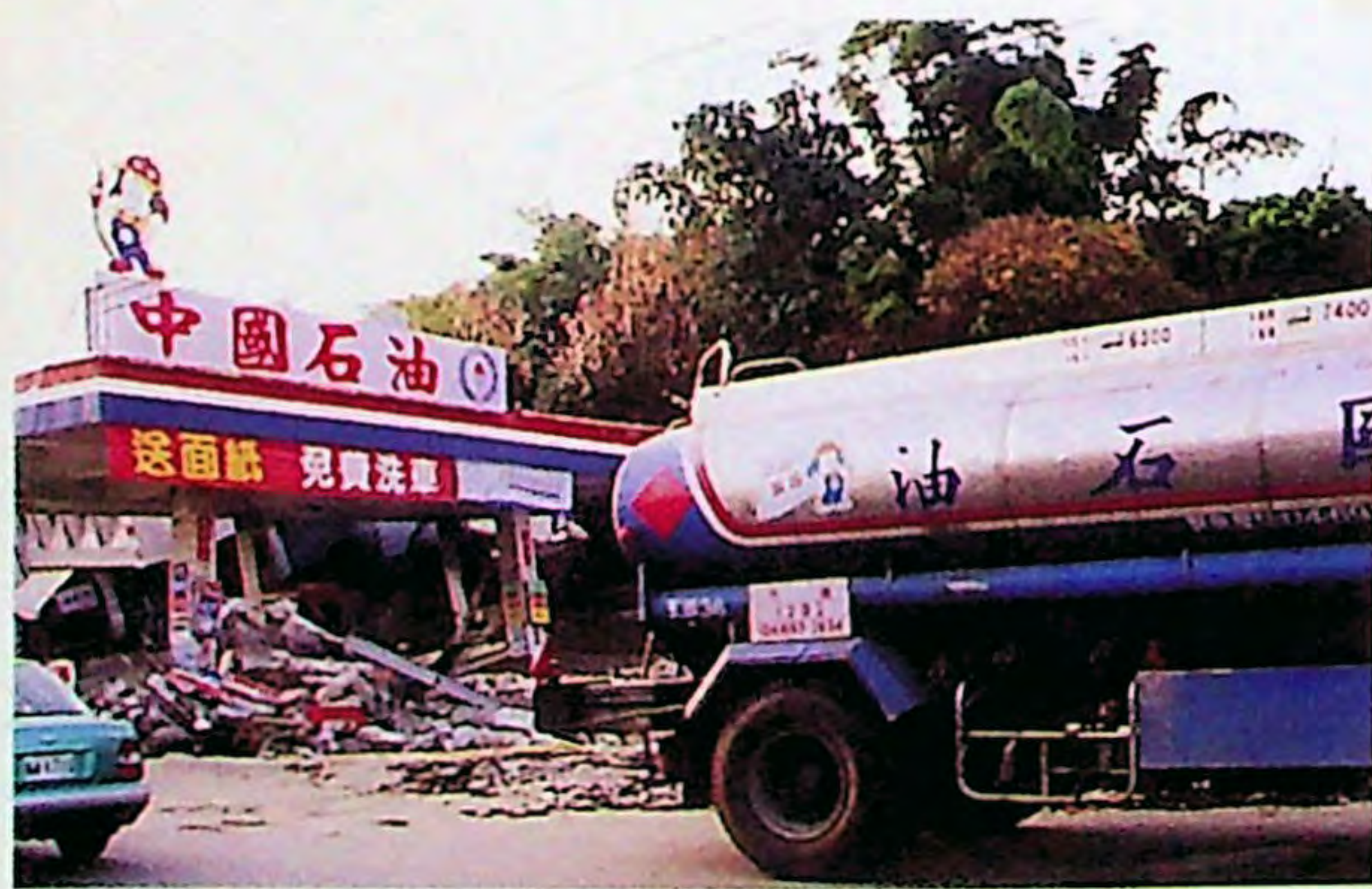
▲中部加油設施損毀，考驗供油系統應變能力。
