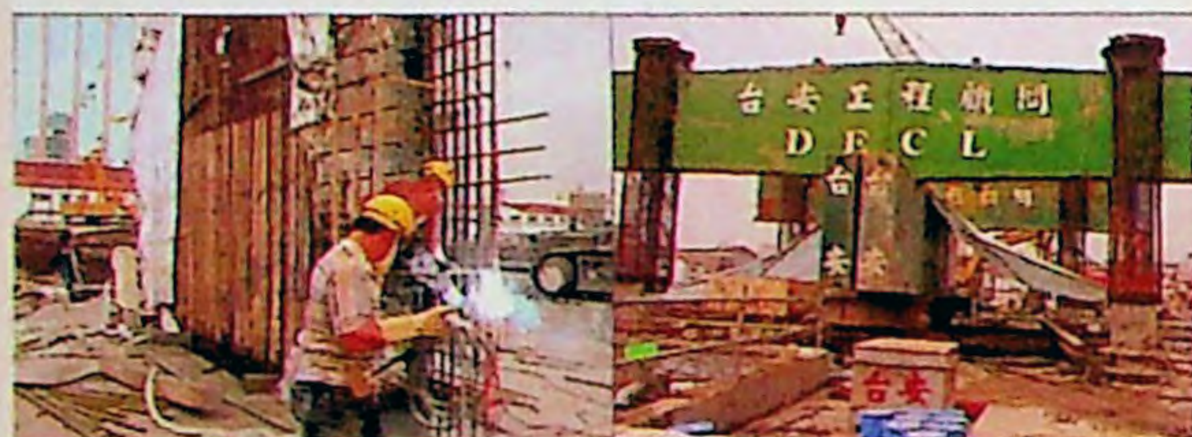
連續壁鋼筋籠施工 基樁抗壓試驗(2000噸)
