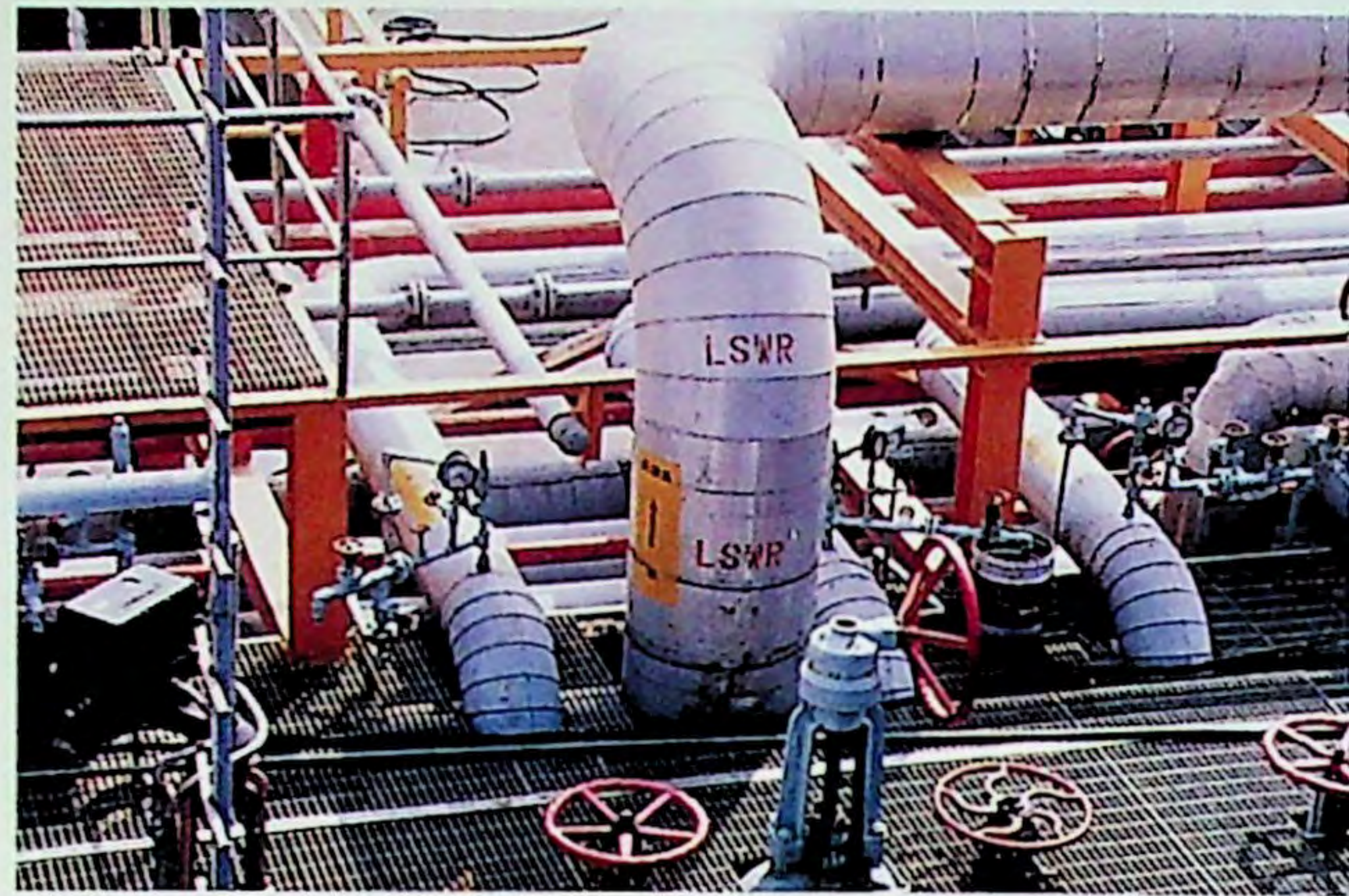
▼「冷底」的流動點低硫燃油管線 外圍是絕熱保溫材料。
