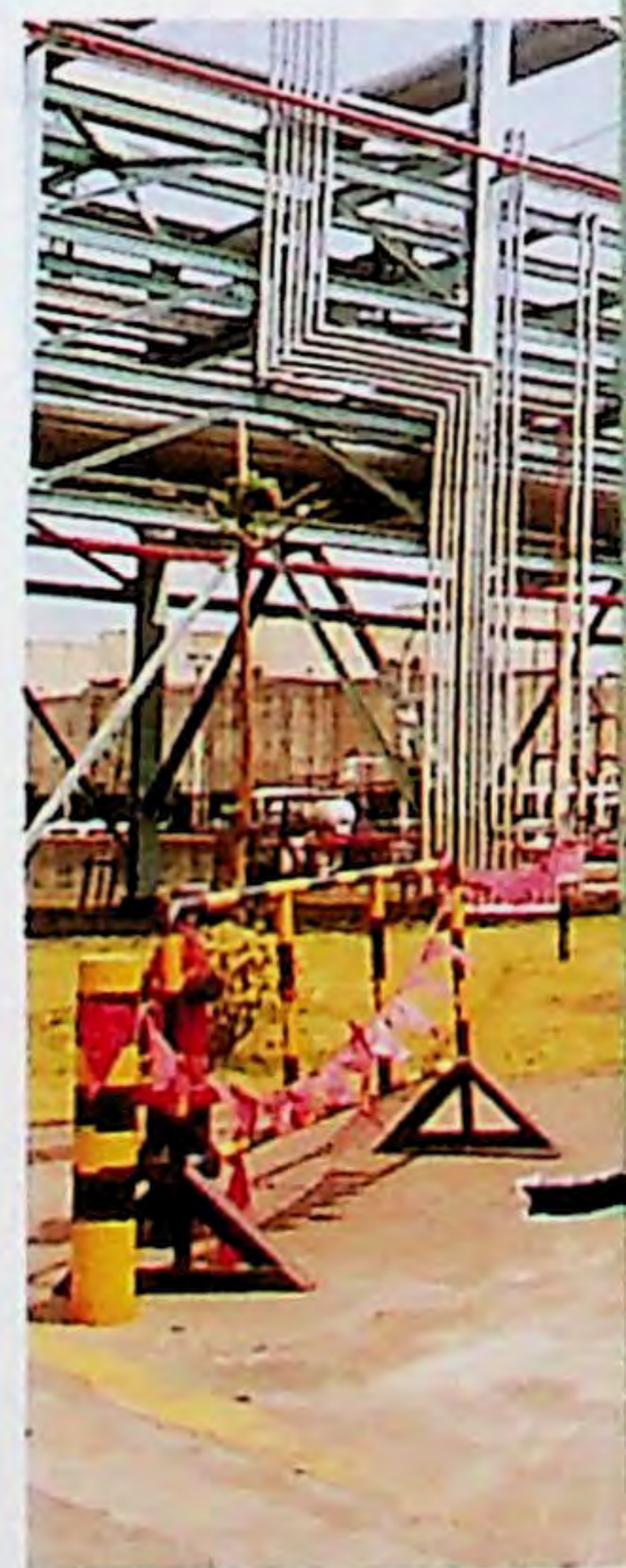
▲臨時趕工完成的灌裝場。
