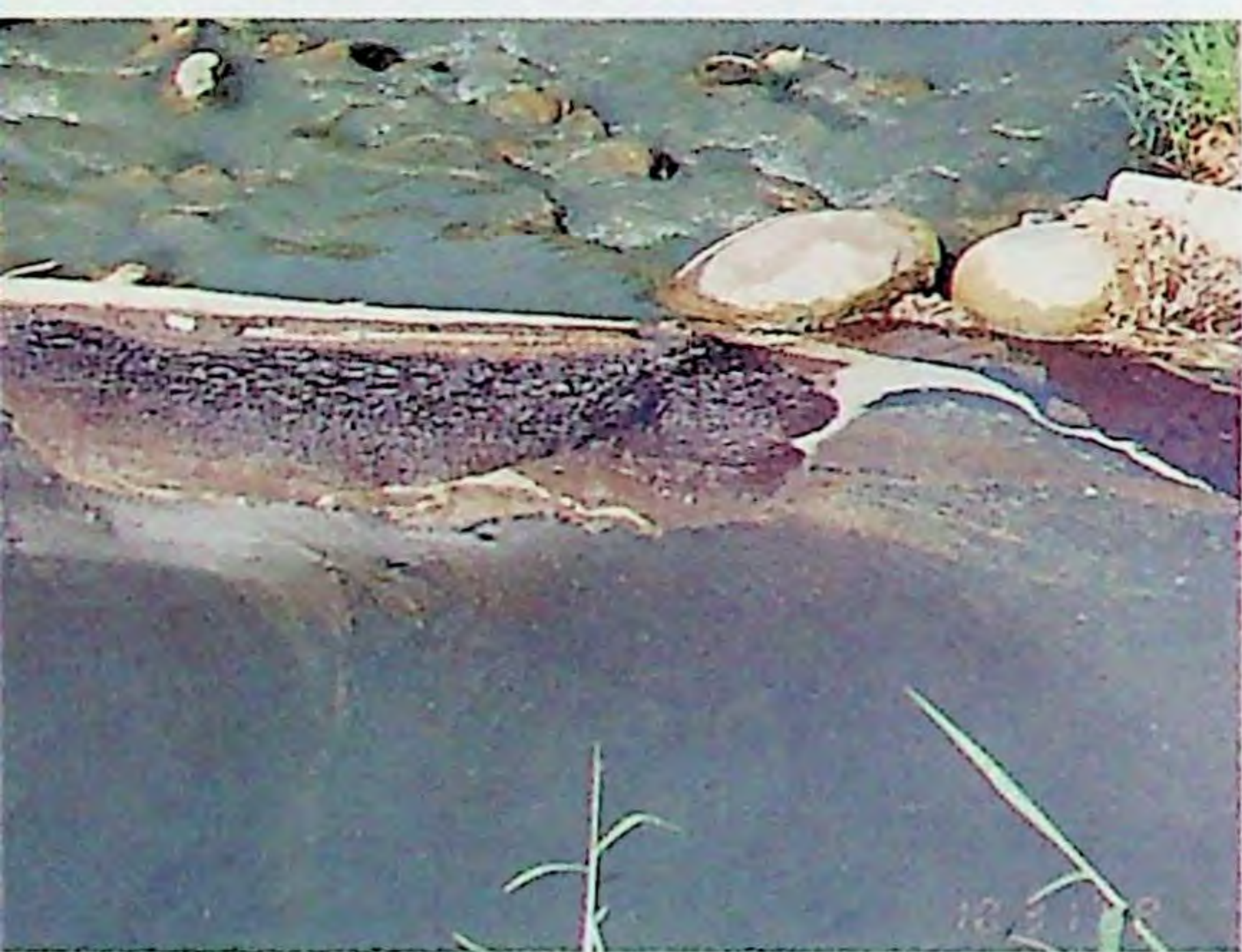
▲截油坑的浮油以泵浦回收。 ▲颱風過後，浮油滲出水面。
