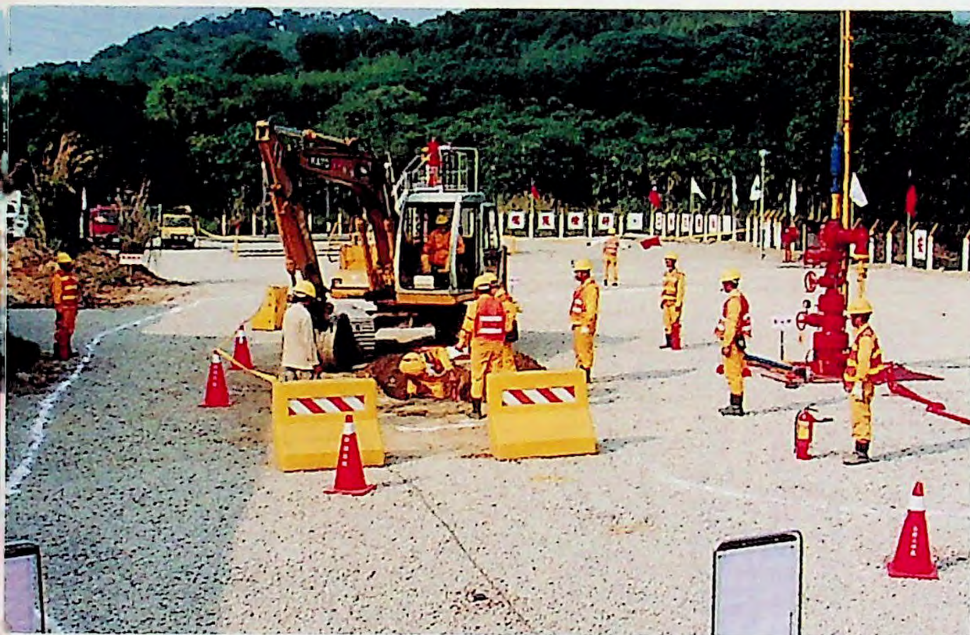
利用GPS檢測地下管線包覆情形。
