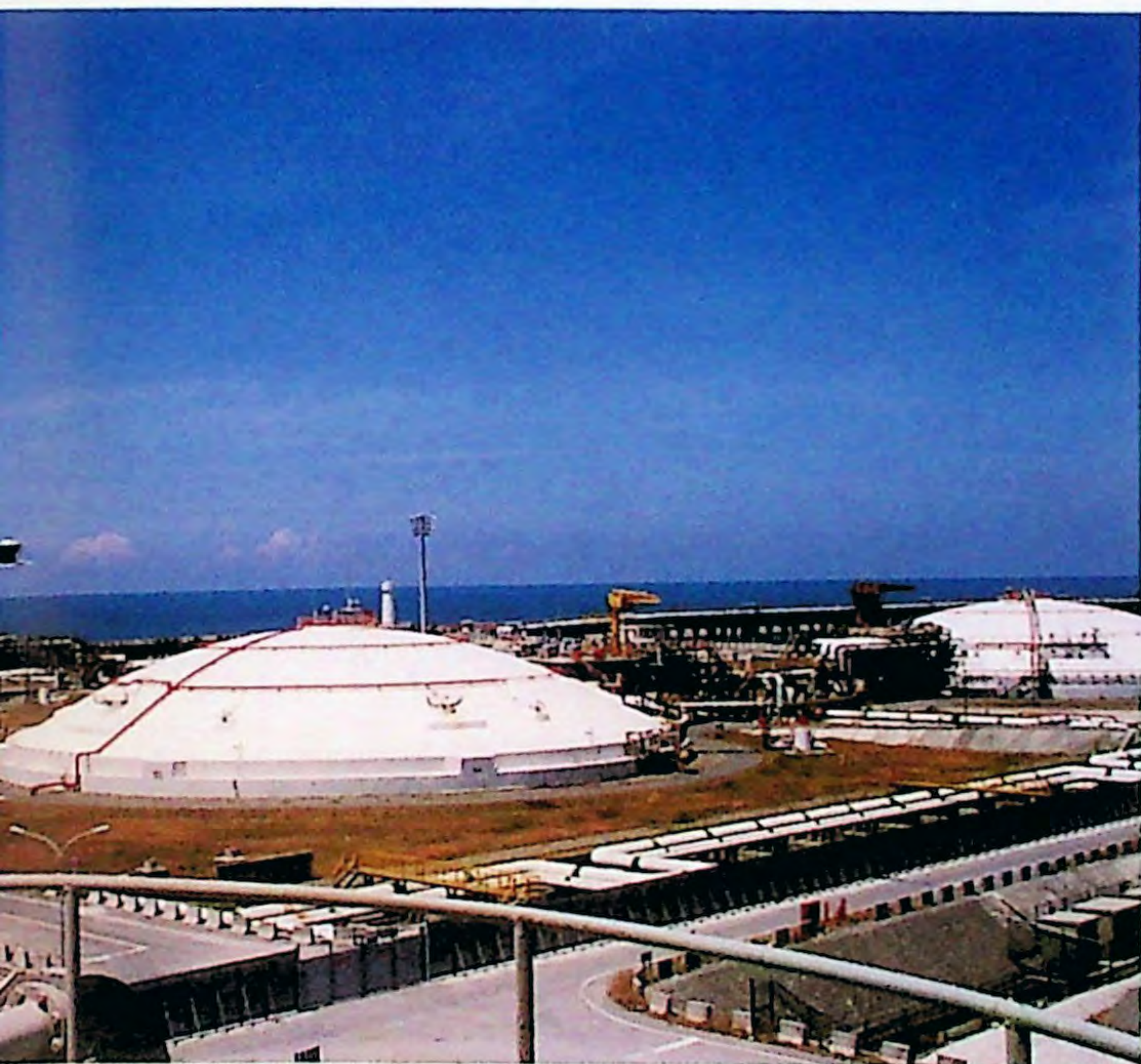
本公司擁有「台灣第一」的優勢，先進的LNG進口碼頭及輸儲設備。
