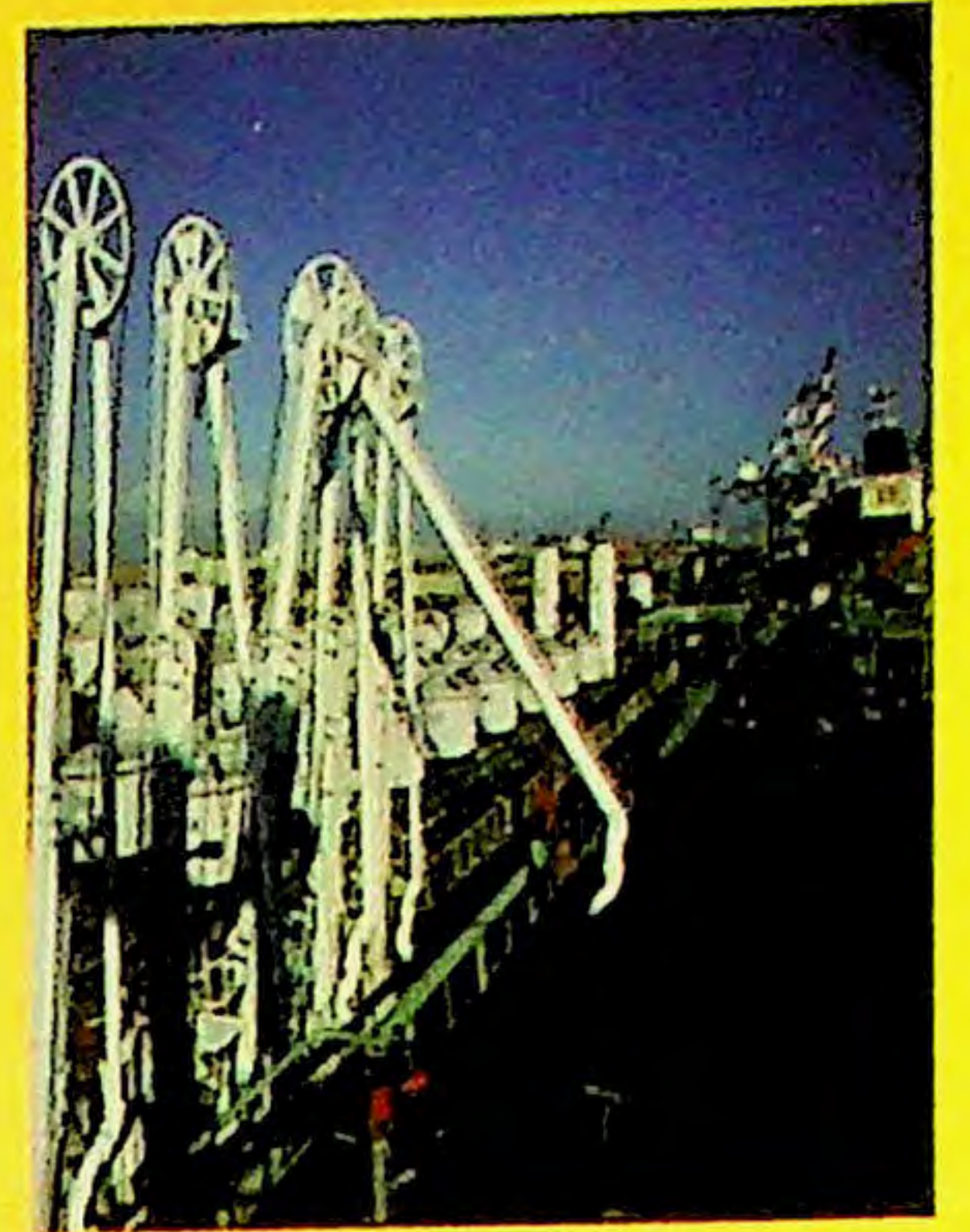
前鎮儲運所碼頭液化石油氣裝卸處
