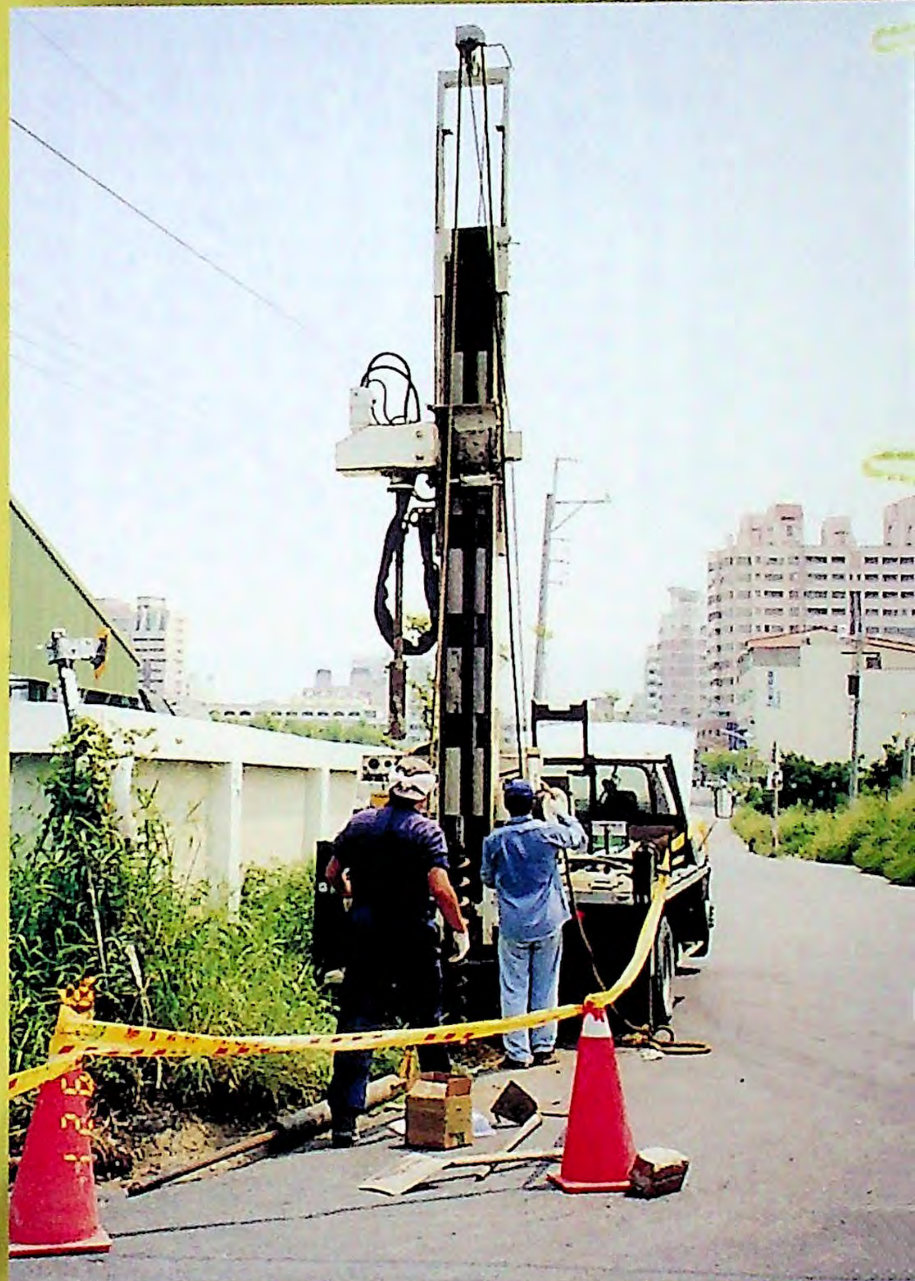
整治小組自場址一公里外施打監測井，以確認污染範圍。(攝影：魏光良)
