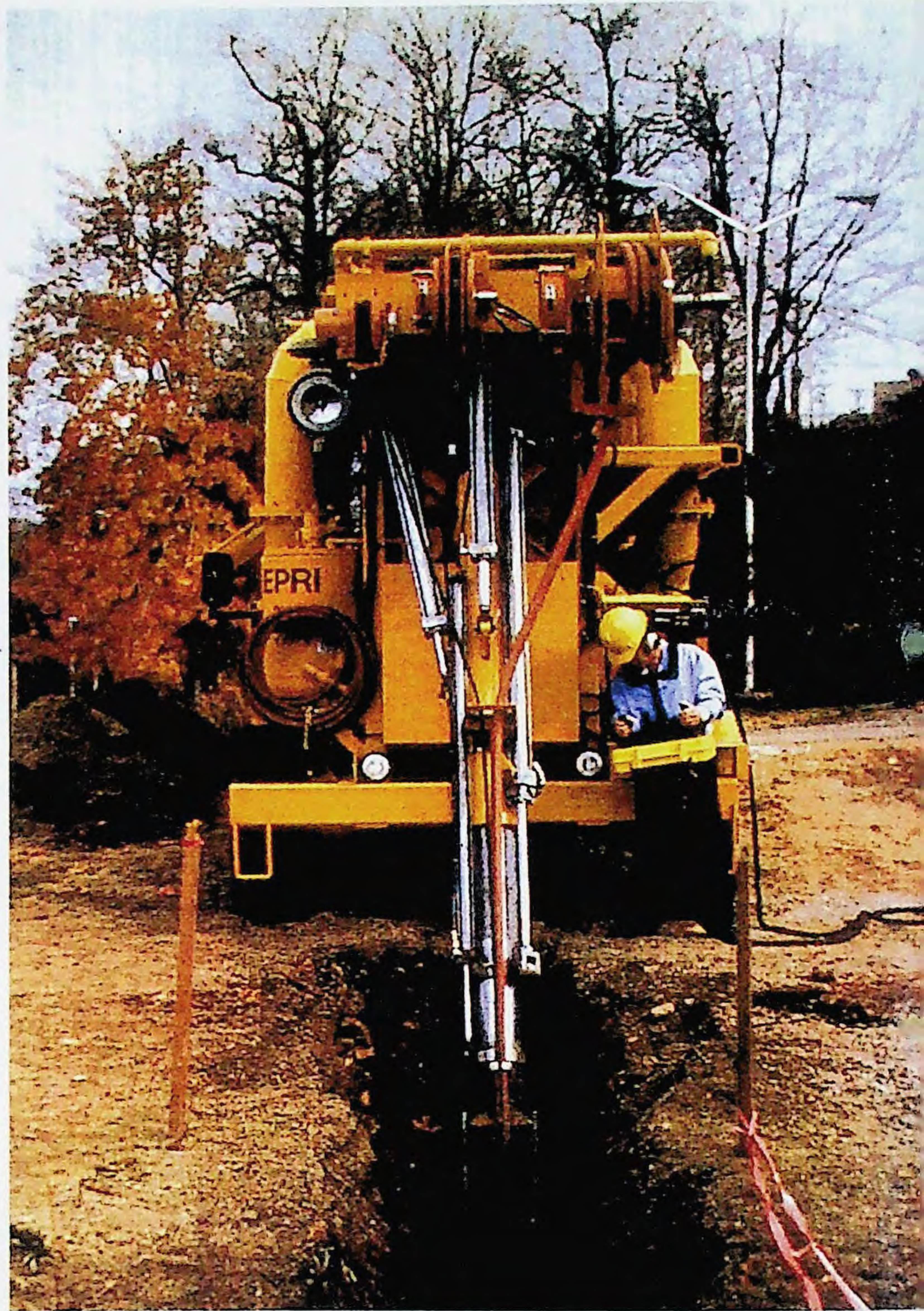
柔手挖土機甚至還配備有輕便的手提遙控器，以提高挖掘的精準性與安全性。
