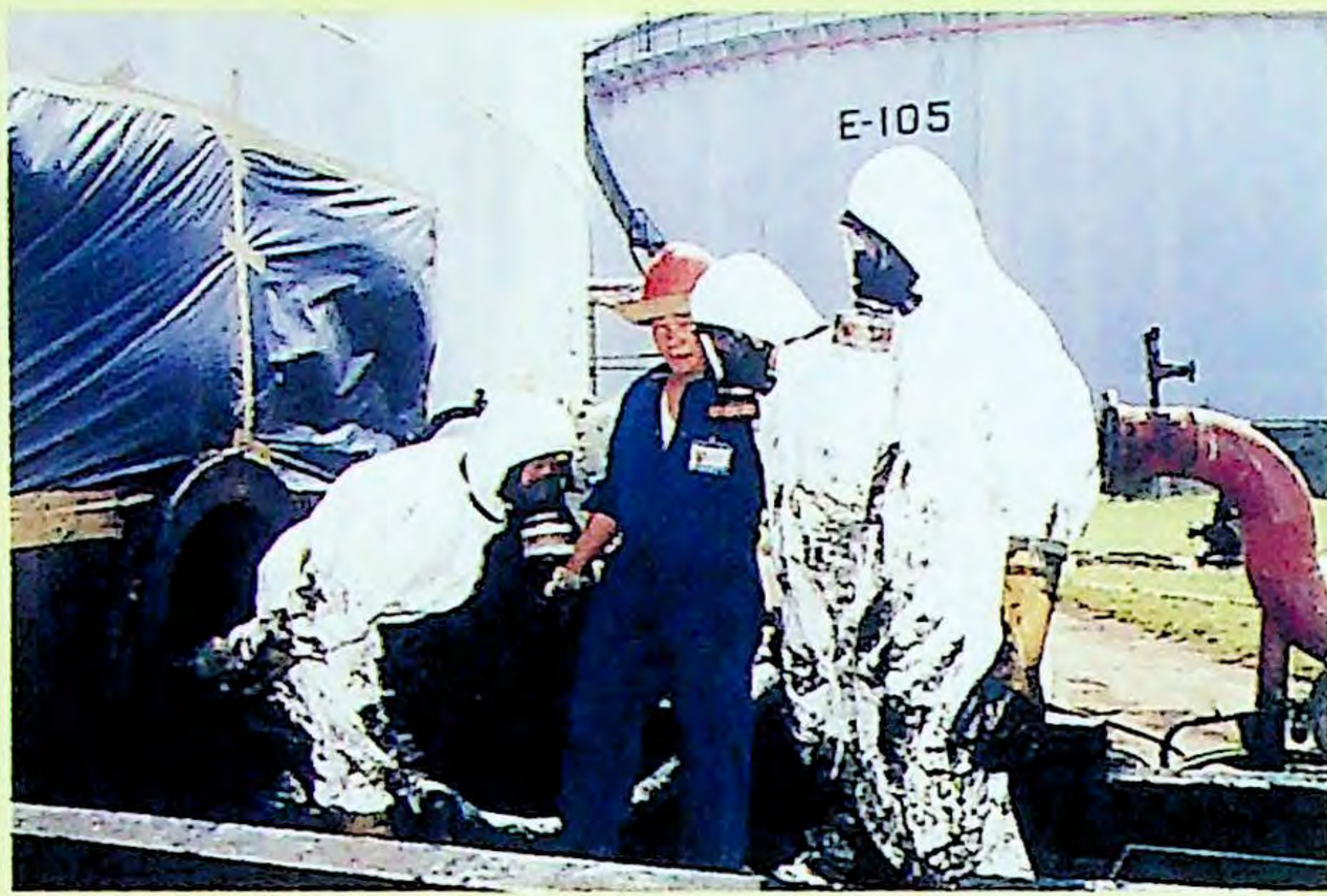
直徑約六十公分的人孔是油槽對外的主要通道。
