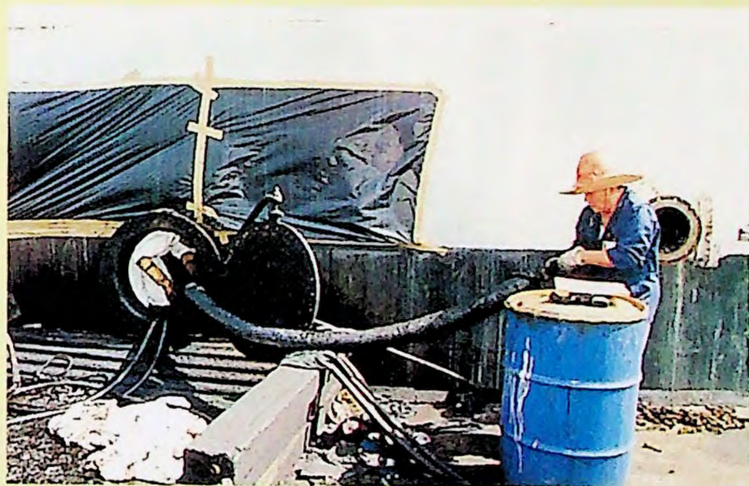
利用抽油管抽出油槽內的殘存油泥。
