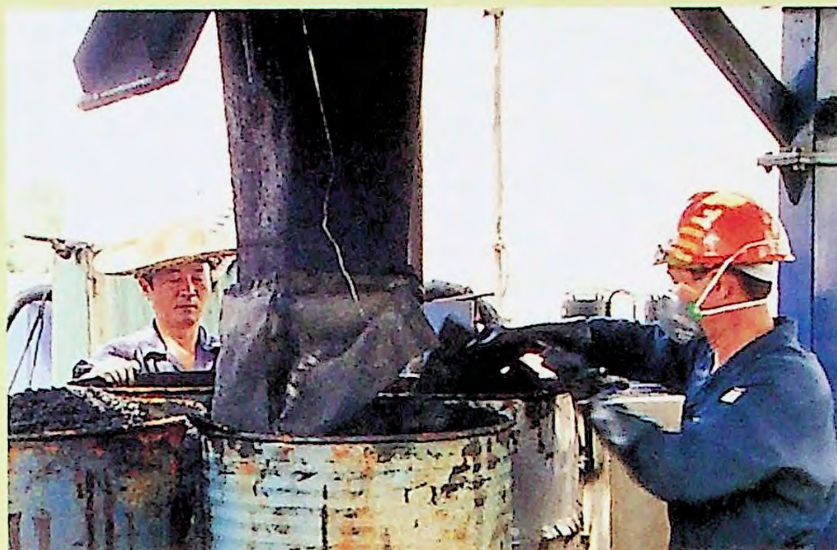
殘餘的油渣裝桶後將送往焚化爐處理。
