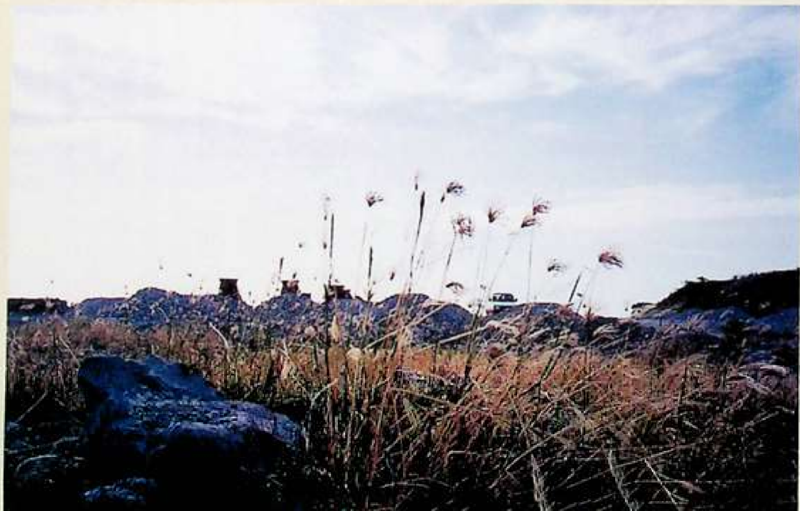
進行中的填海造陸工程。
