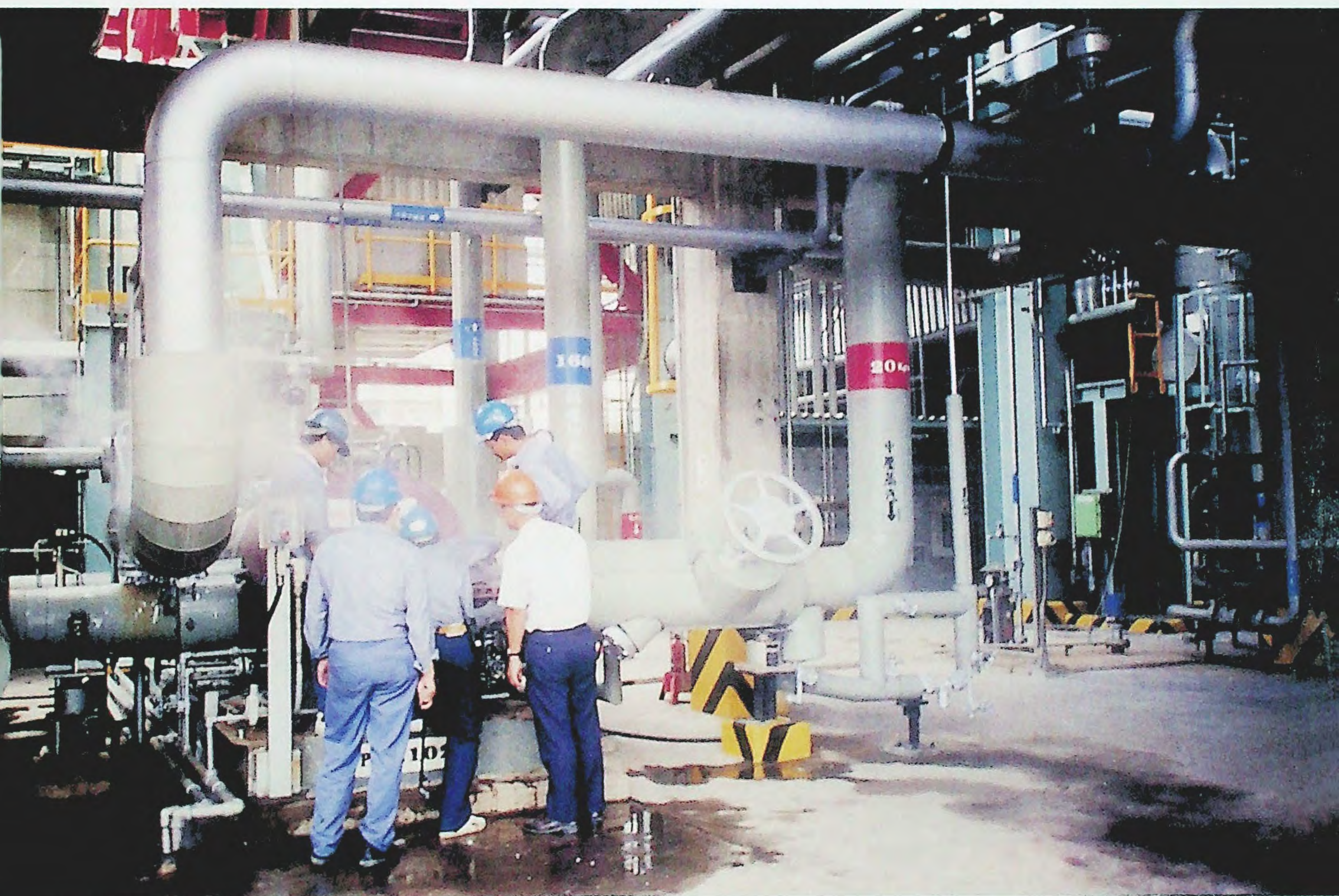
裝建完成，進行試爐。
