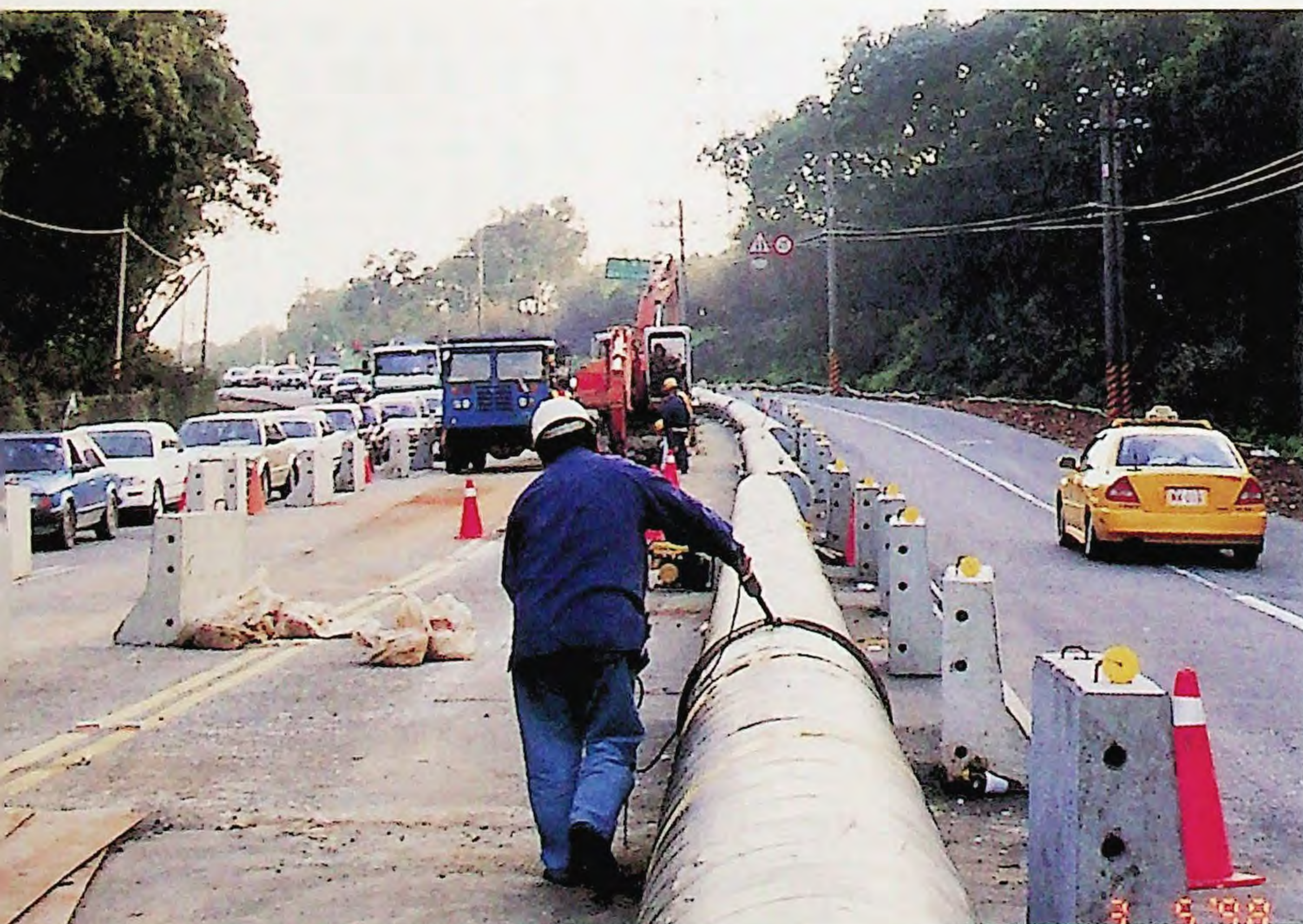
交通要道旁施工更添工程複雜性。
