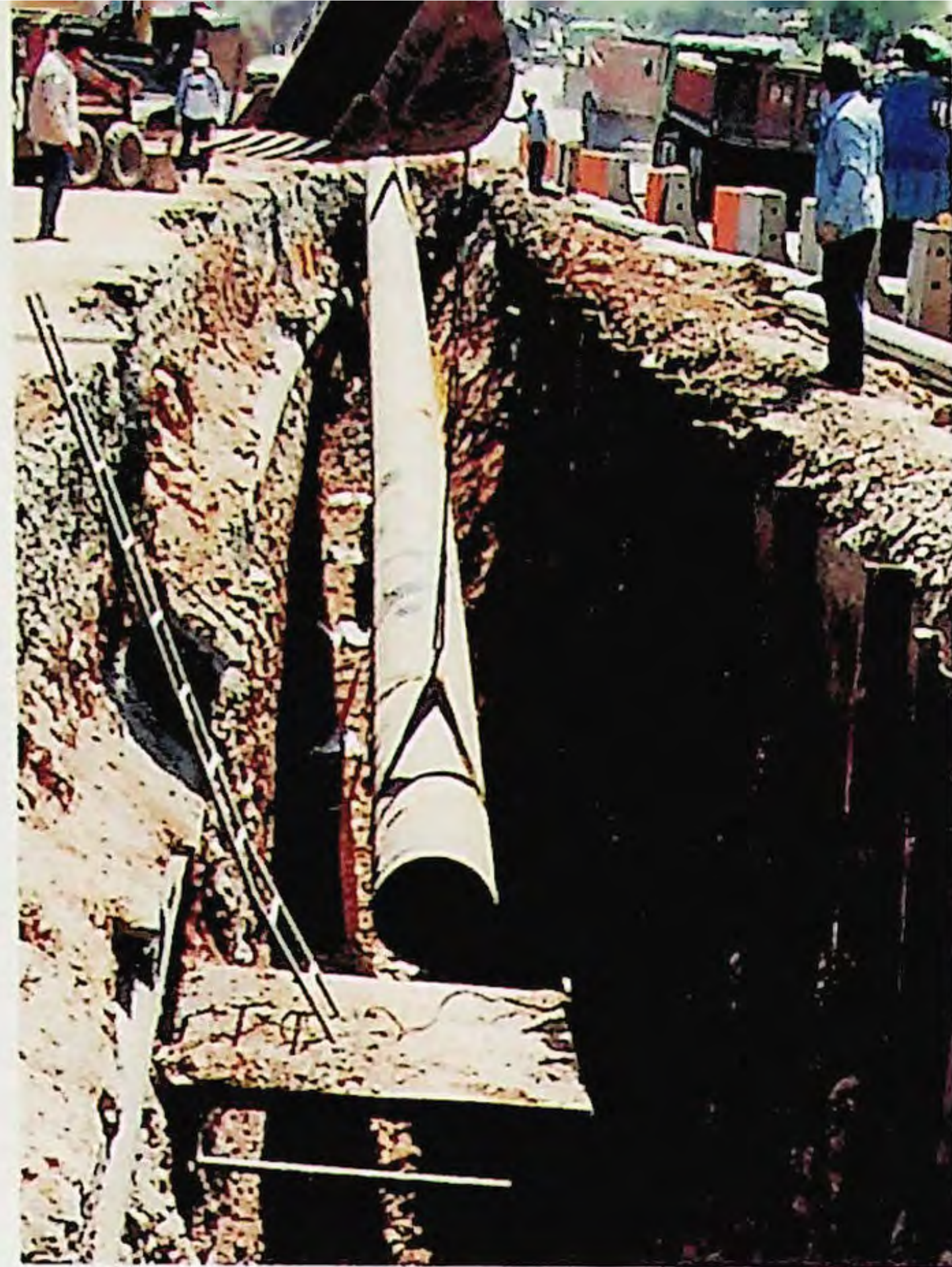
輸氣管線配管工作。
