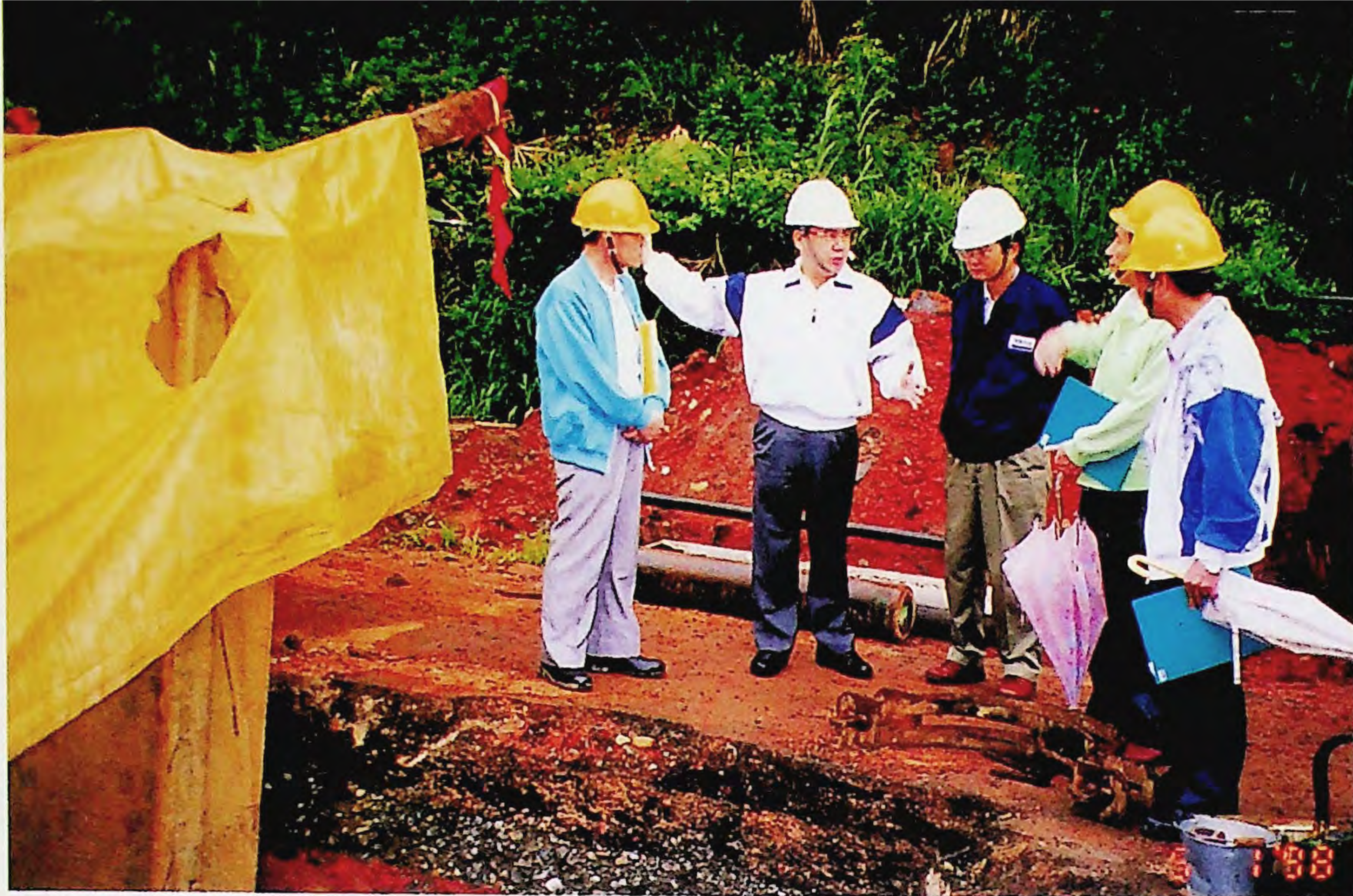
高階主管關心工程進度，親赴現場督導。
