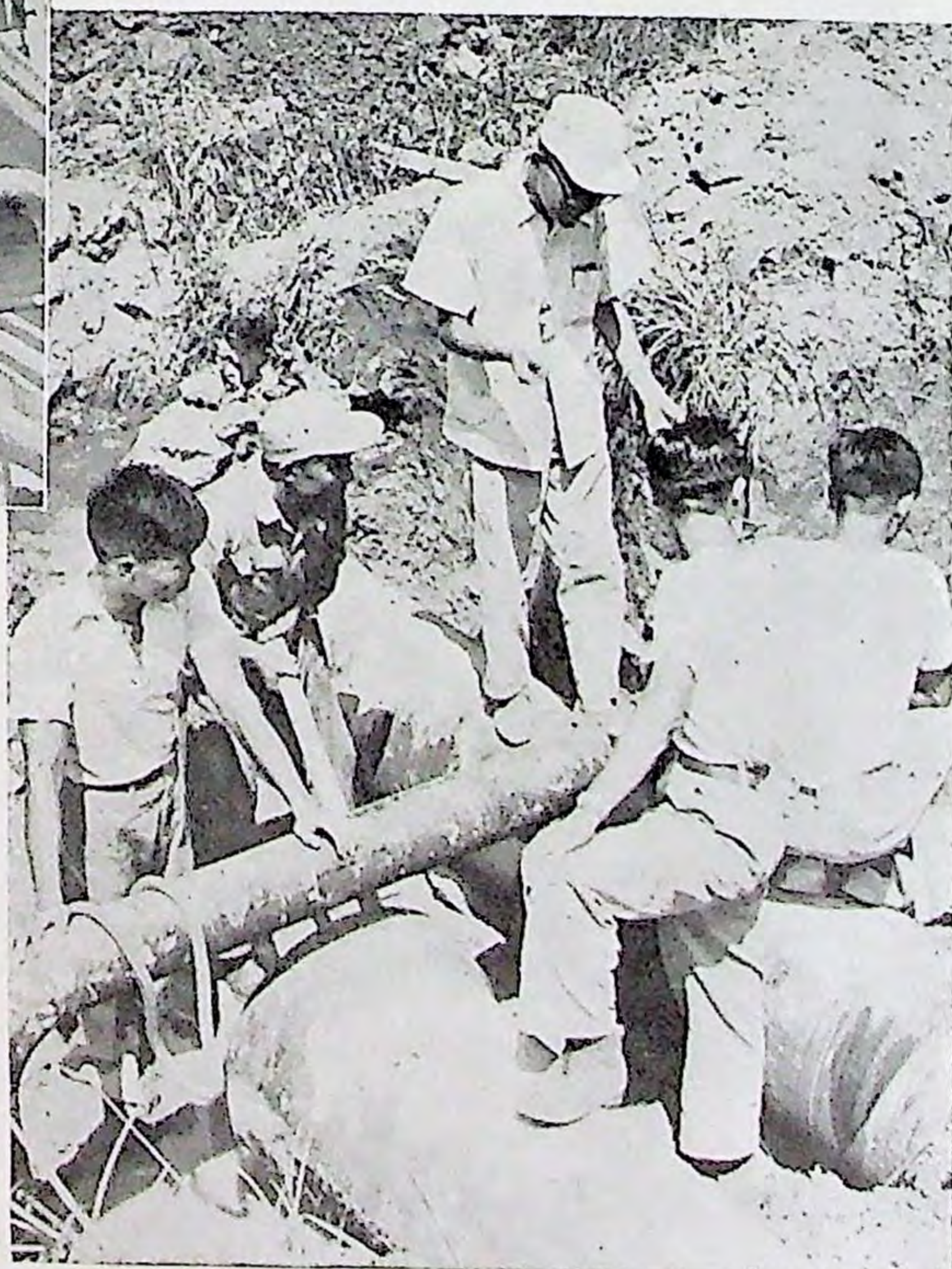
↓ 給水工場副工程師賴燦龍(中)解說地下油管補修程序。
