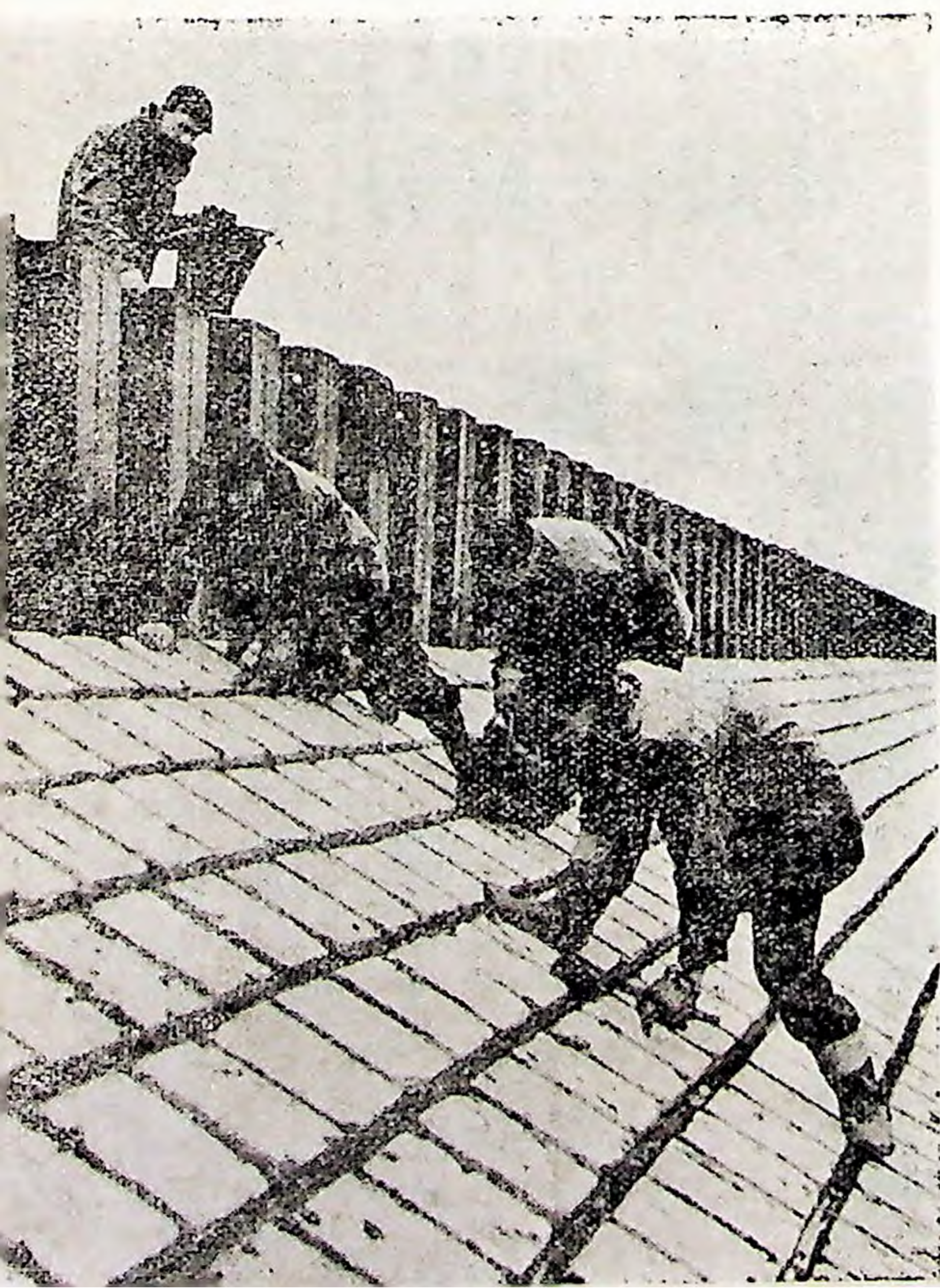
→ 將柏油加壓注入洋灰混凝土底層的施工情形。
