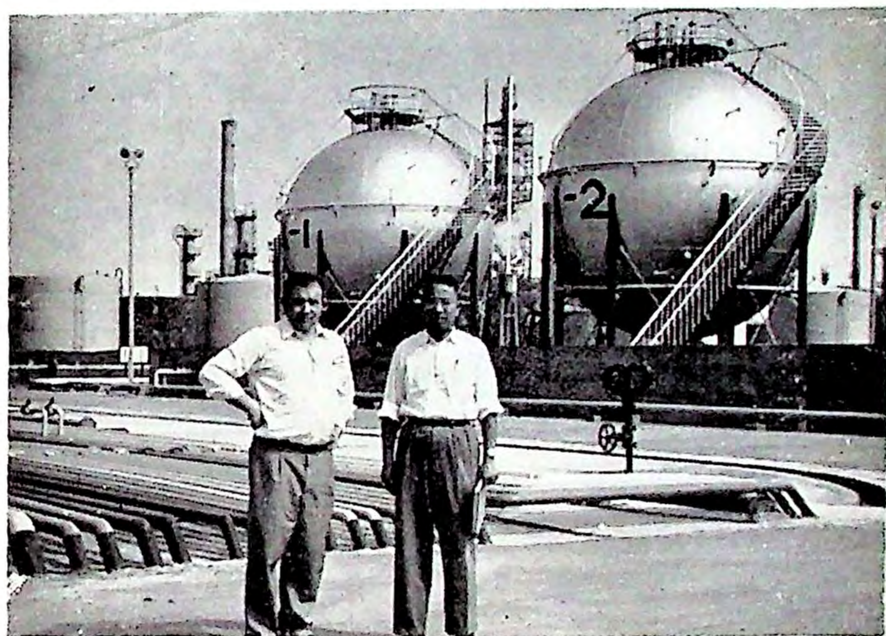
赴（左）君 Bocian 派司公油古士德國美，工開初月三于已場工油輕廠高 。槽儲油航的建新觀參待接長組圻自費，宜事配摻油航洽接廠
