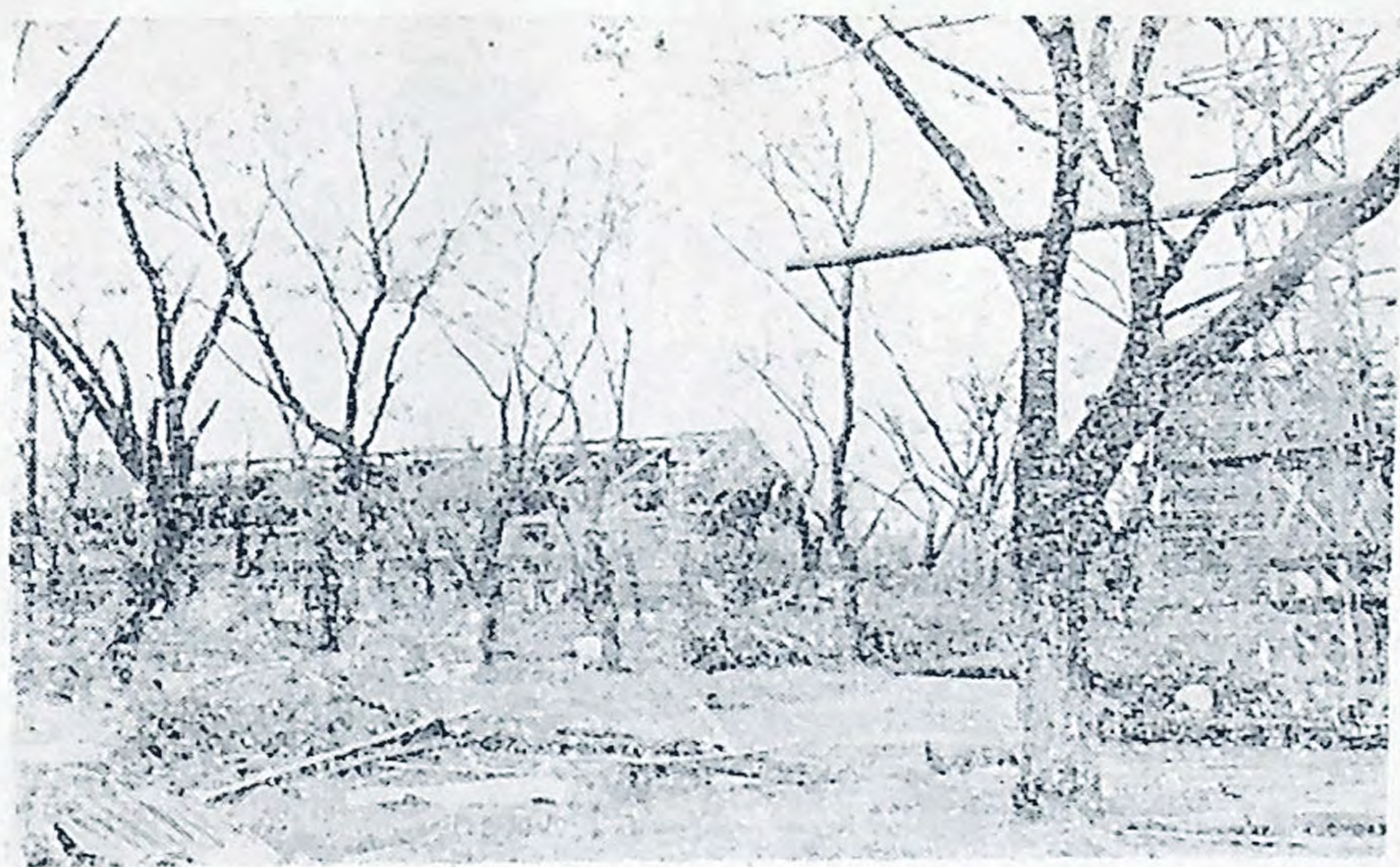
高雄煉油廠修理工場颶風劫後之慘狀
