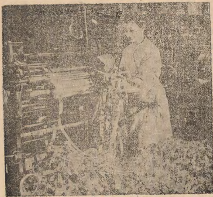
英國工廠中正製造「窗戶」，在轟炸攻擊中，飛機把這種金屬箔片拋下去，以干擾德國的雷達。
