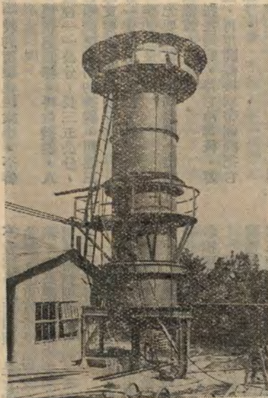
直立式熱處理爐
