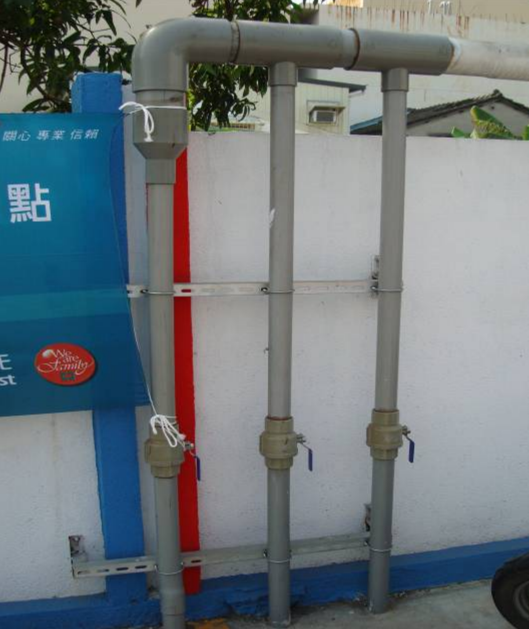
PVC油氣排放管固定角鐵
