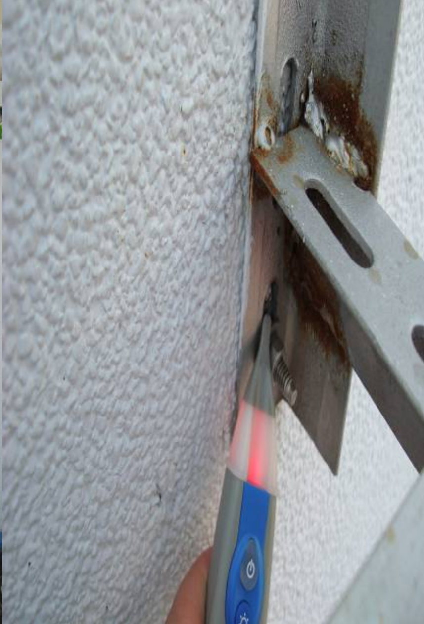
PVC油氣排放管固定角鐵
