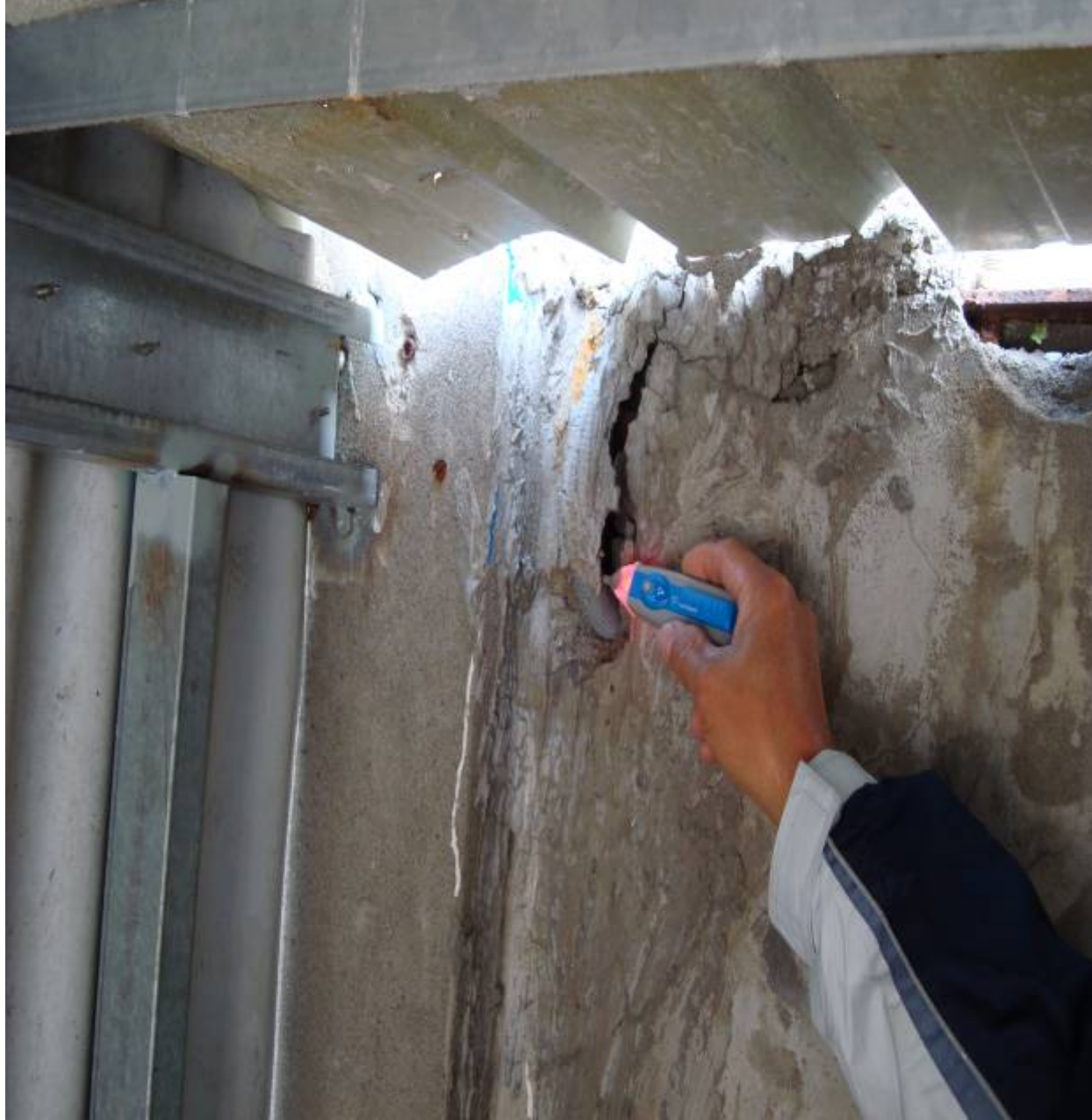
車庫遮雨棚金屬骨架
