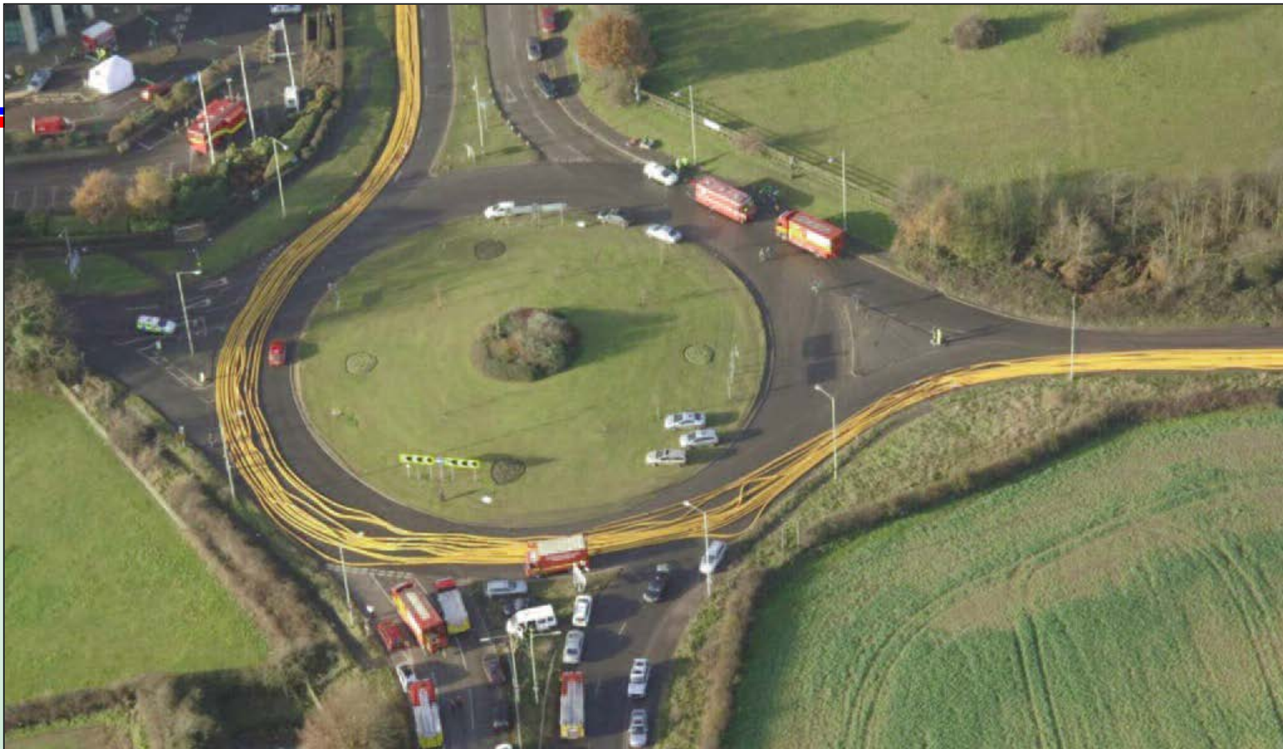
救災中消防水線搭接照片
