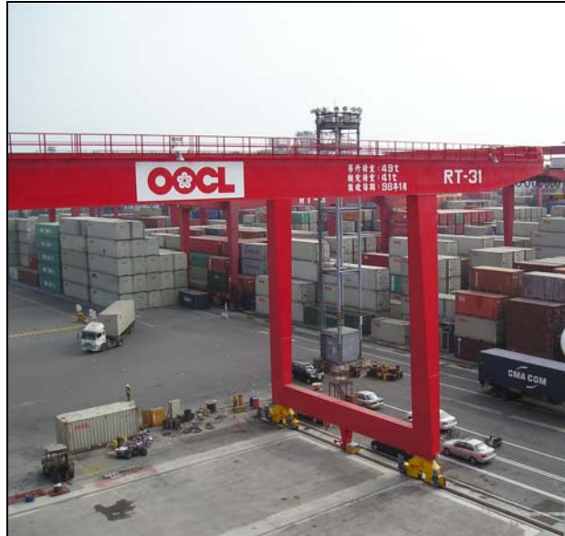
圖 1 港區貨櫃場中的橋型起重機
