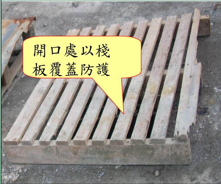
屋頂開口防護措施現場照片
