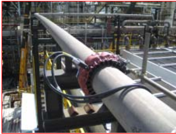
圖十一 利用導波檢測塔槽至空冷器之管線
