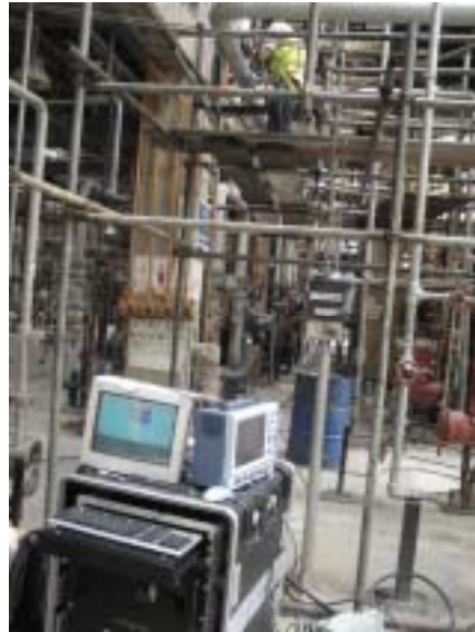
圖八 現場電磁超音波儀器檢測管線情形
