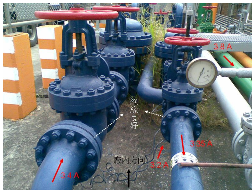
圖 13 G 公司之 8 吋 SYN GAS、6 吋 CO 管及 8 吋水管
