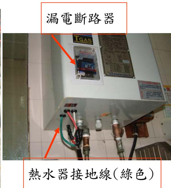
(3)臨時電源裝設漏電斷路器實例圖
