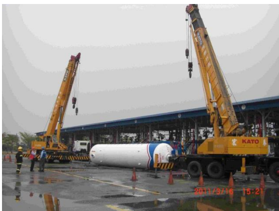
吊車扶正作業
