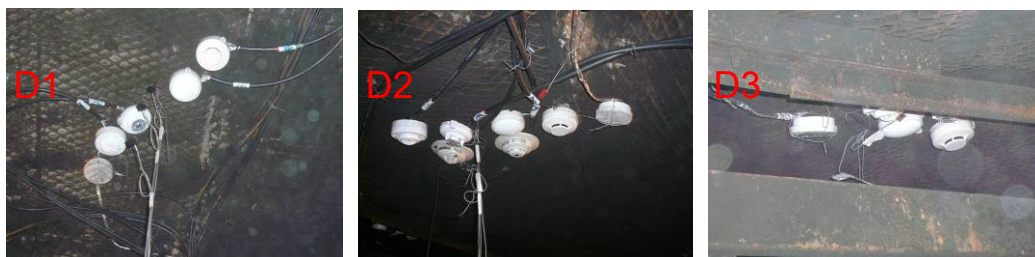
圖 2 偵溫及偵煙式探測器配置概況
