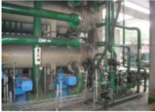
熱交換反洗油手動方式改善為自動化控制
