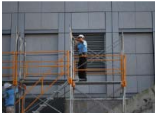
圖 10 至上層組搭立架與交叉拉桿
