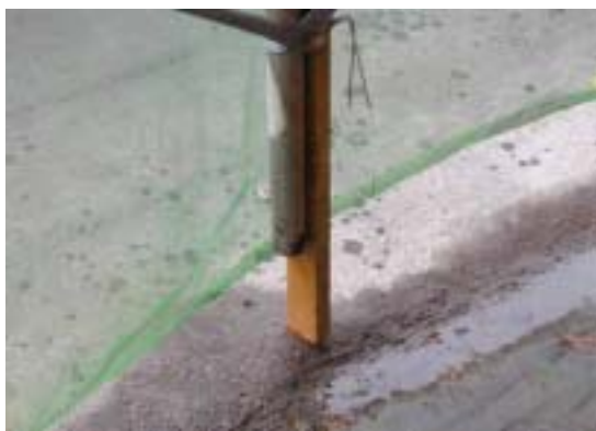
圖 4 以木板或鋼筋搭接取代可調整型基腳座鉸
