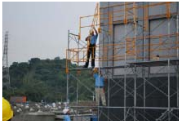
圖 12 拆除上層之先行扶手框，並裝至下層
