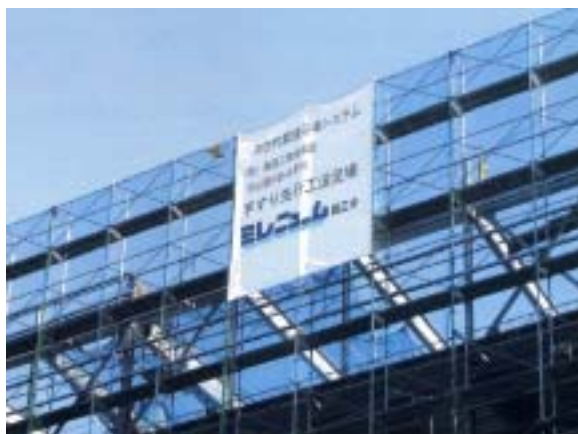
圖 16 日本使用扶手先行工法之工地現況
