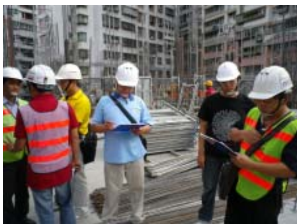
圖 15 工地現場之審核
