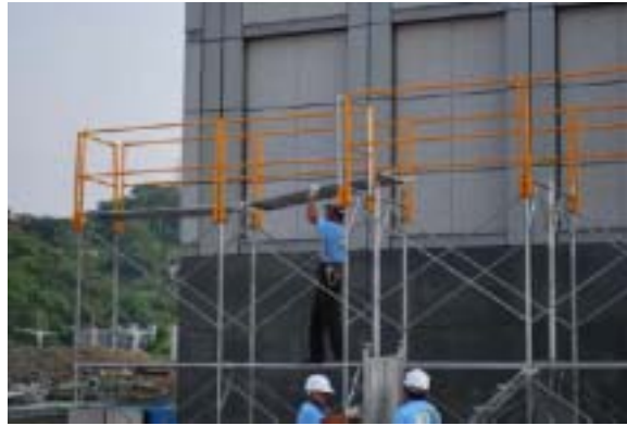
圖 11 拆除作業時保留扶手框
