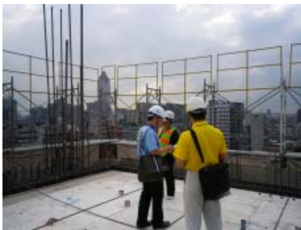
圖 14 工地現場使用扶手先行工法
