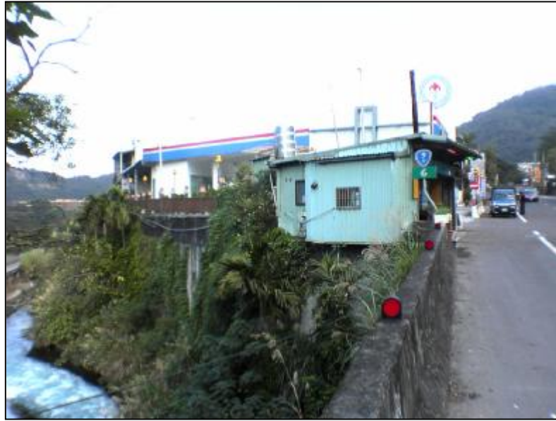
圖四：屈尺加油站站屋
